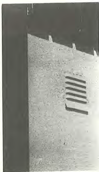
Figur 5.79: Sandwich-elementfacade af træfiberplader med mineralkorn-finish
