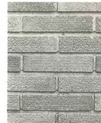
Figur 5.60: Blankt teglmurværk. Præget maskinsten, halvstensforbandt med vandfaldsfuger
