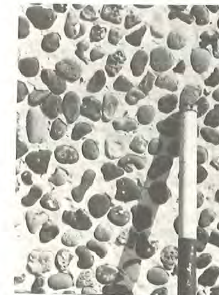
Figur 5.66: Betonoverflader med frilagte stenmaterialer; granitkærver (tv) og søsten (th)
